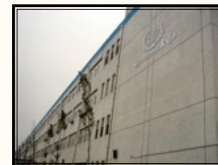
La nouvelle usine de Heintzman dans Beijing, Chine
